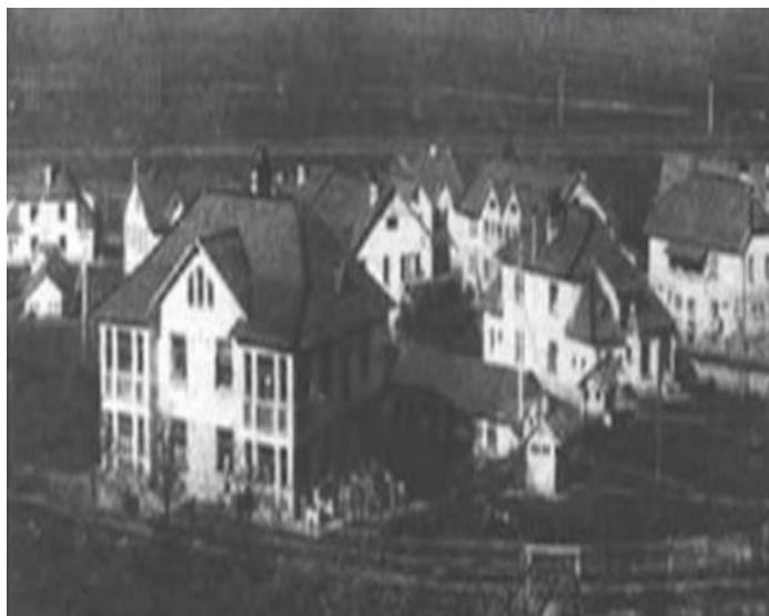
Рис. 1. Двухэтажные дома рабочего поселка на старых промыслах
