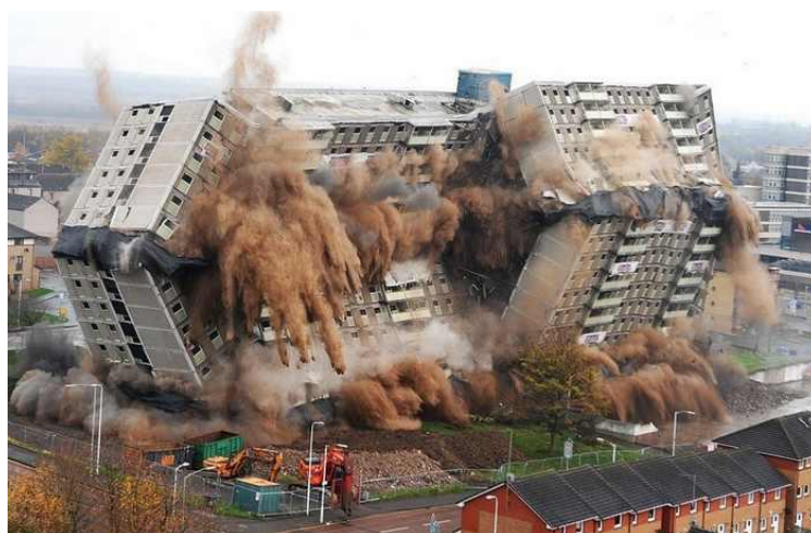
Рис. 2. Взрывной метод обрушения зданий
