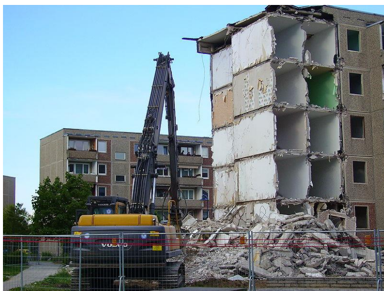
Рис. 1. Механический метод обрушения зданий
